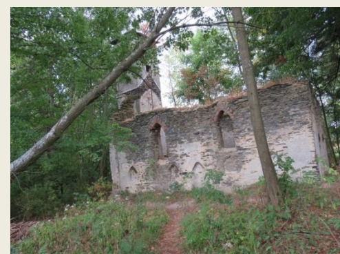
Ruina kaple sv. Anny (Hutov, okr. Bruntál)
